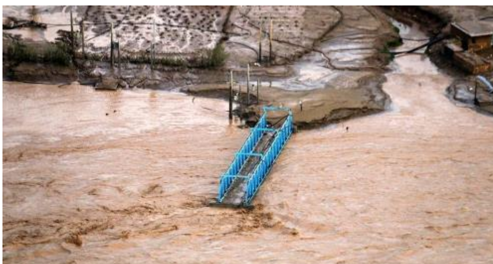
شکل ۱-۲۹- تخریب پل ارتباطی یکی از روستاهای مجاور رود کشکان در مسیر پلدختر
