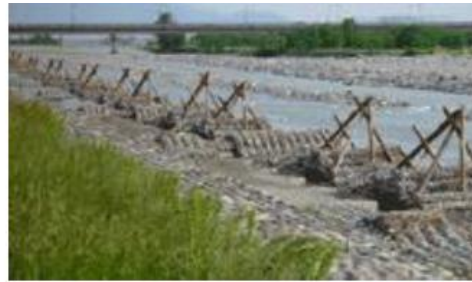
۱- تقویت کناره‌های رودخانه‌ها با استفاده از خاکریزی و سنگ‌چینی
