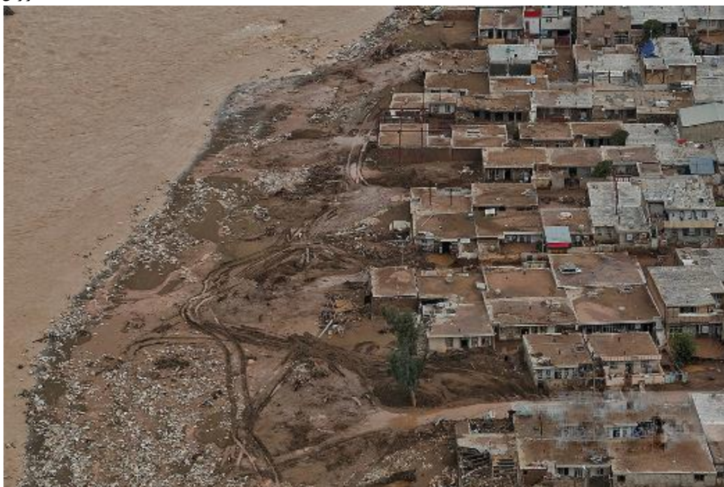
شکل ۱-۲۶- تخریب اماکن مسکونی مجاور رود کشکان در شهر معمولان
