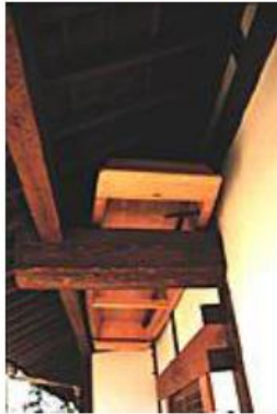
۴- تعبیه محلی برای قایق در سقف منازل
