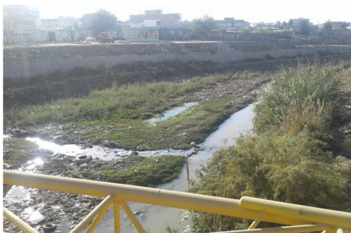
شکل ۱-۴ کاهش عرض موثر رودخانه در محل پل آخوندآباد
