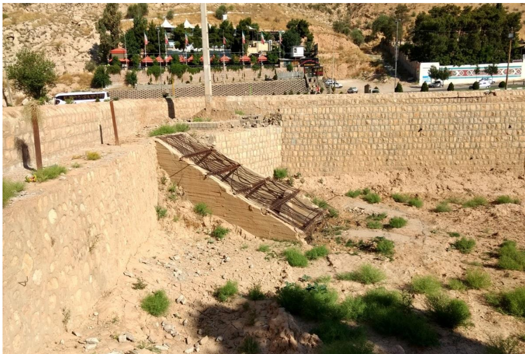
شکل ۲-۱۴ تصویر حوضچه آرامش و کانال تعبیه شده در آن به منظور انتقال سیلاب
