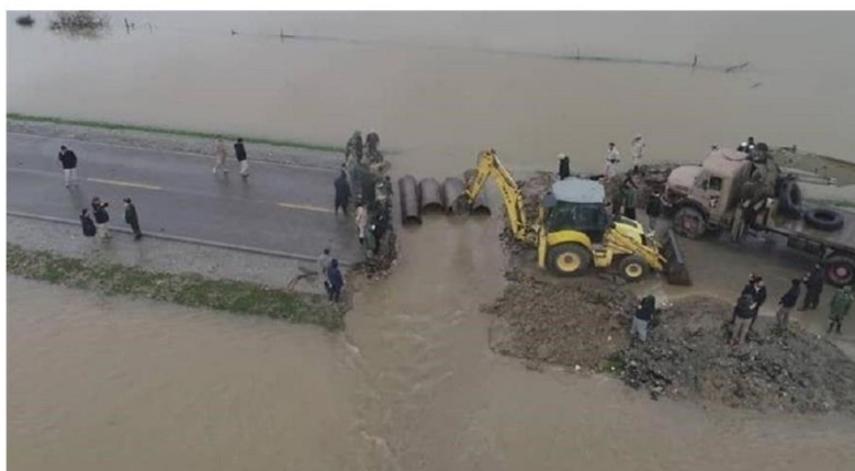
شکل ۱-۳ برش عرضی و تخریب جاده آق قلا-اینچه برون برای تخلیه سیل آق قلا
